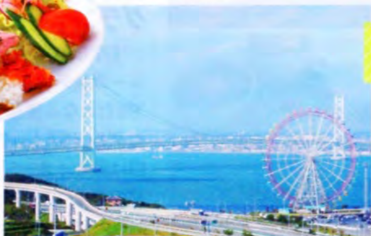
写真提供:本州四国連絡高速道路(株)
