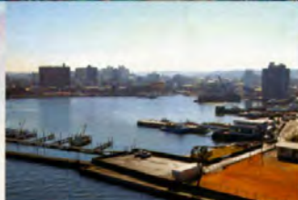
橋の上からは木更津港が！船をよけるためのこの高さだ。
