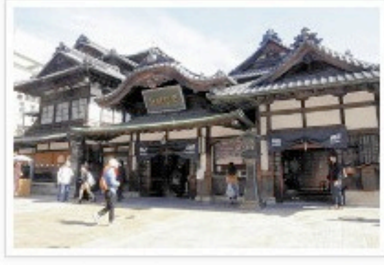
修復工事に入ることが決まった道後温泉本館。工事中は松山市への観光客減少が懸念される（松山市道後湯之町で）
