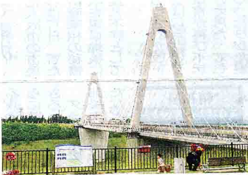
優美な姿の斜張橋・内灘大橋
